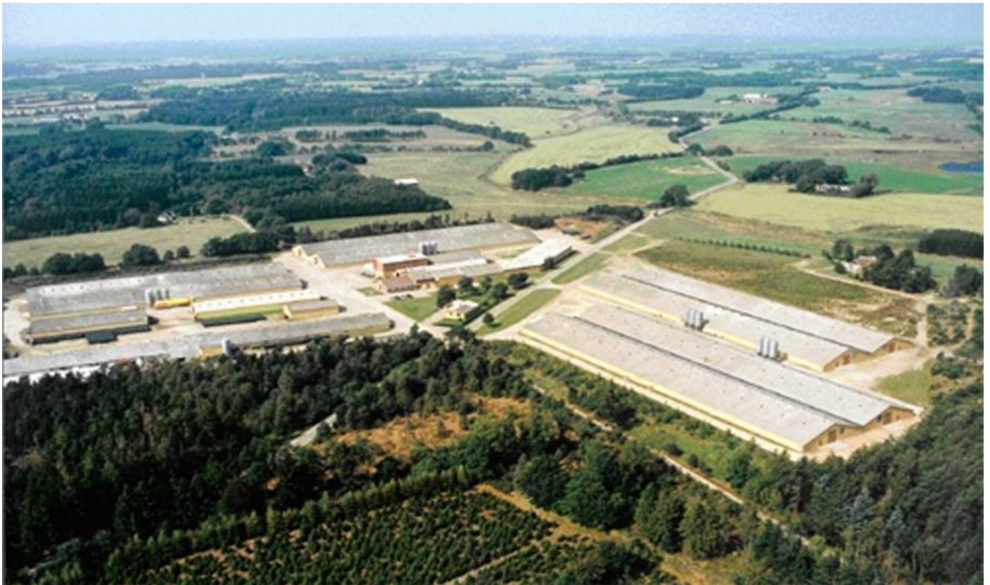
Обзорная фотография компании DanBroiler A/S
